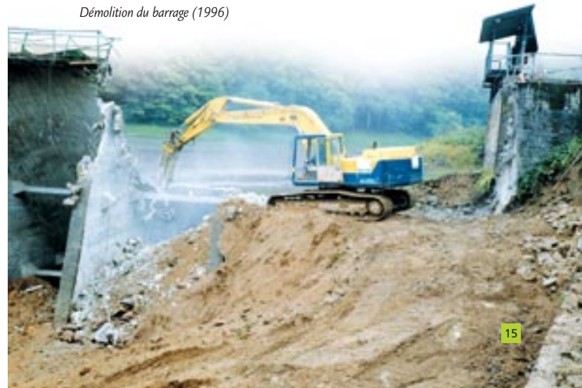
Démolition du barrage (1996)
