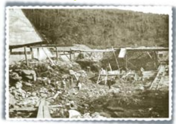
La construction du barrage de Kernansquillec (1920-1922)
